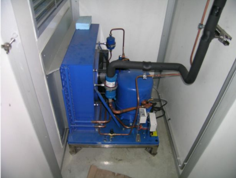
Холодильный агрегат с испарителем и конденсатором
